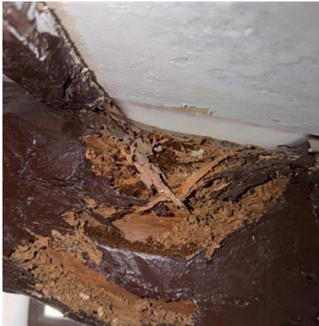
Patologías estructura horizontal
